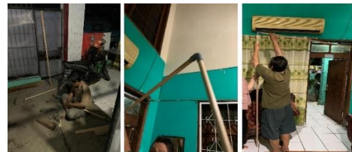
Sumber : Dok. Pribadi Gambar 9. Proses Pembuatan Instalasi
