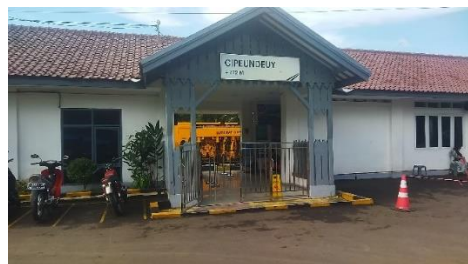
Gambar 4. Tampak Depan Close up Stasiun Cipeundeuy yang masih dilestarikan desain Historisnya
