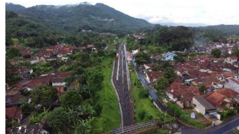
Gambar 21. Ujung barat dari Stasiun Cipeundeuy yang berbatasan langsung dengan Jalan Raya Bandung-Tasikmalaya
