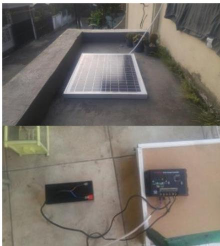
Gambar 9. *Solar Cell*, *Solar Charger Control*, dan *Accumulator*.
